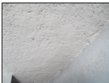
Photo N° 610 ECH-N°2 FLOCAGE -- LOCAL VELO Plafonds Blanc cotonneux
